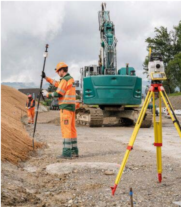
Figura 2: Olvídense de la burbuja y aumente la productividad midiendo los puntos con el jalón posicionado de cualquier forma.
