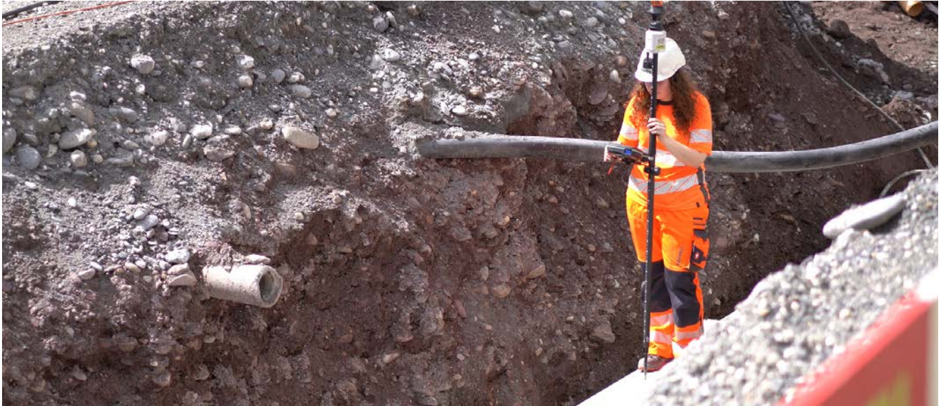
Figura 5: Mejora en la productividad con la compensación de la inclinación y mejora simultánea de la seguridad del operador en condiciones difíciles.
