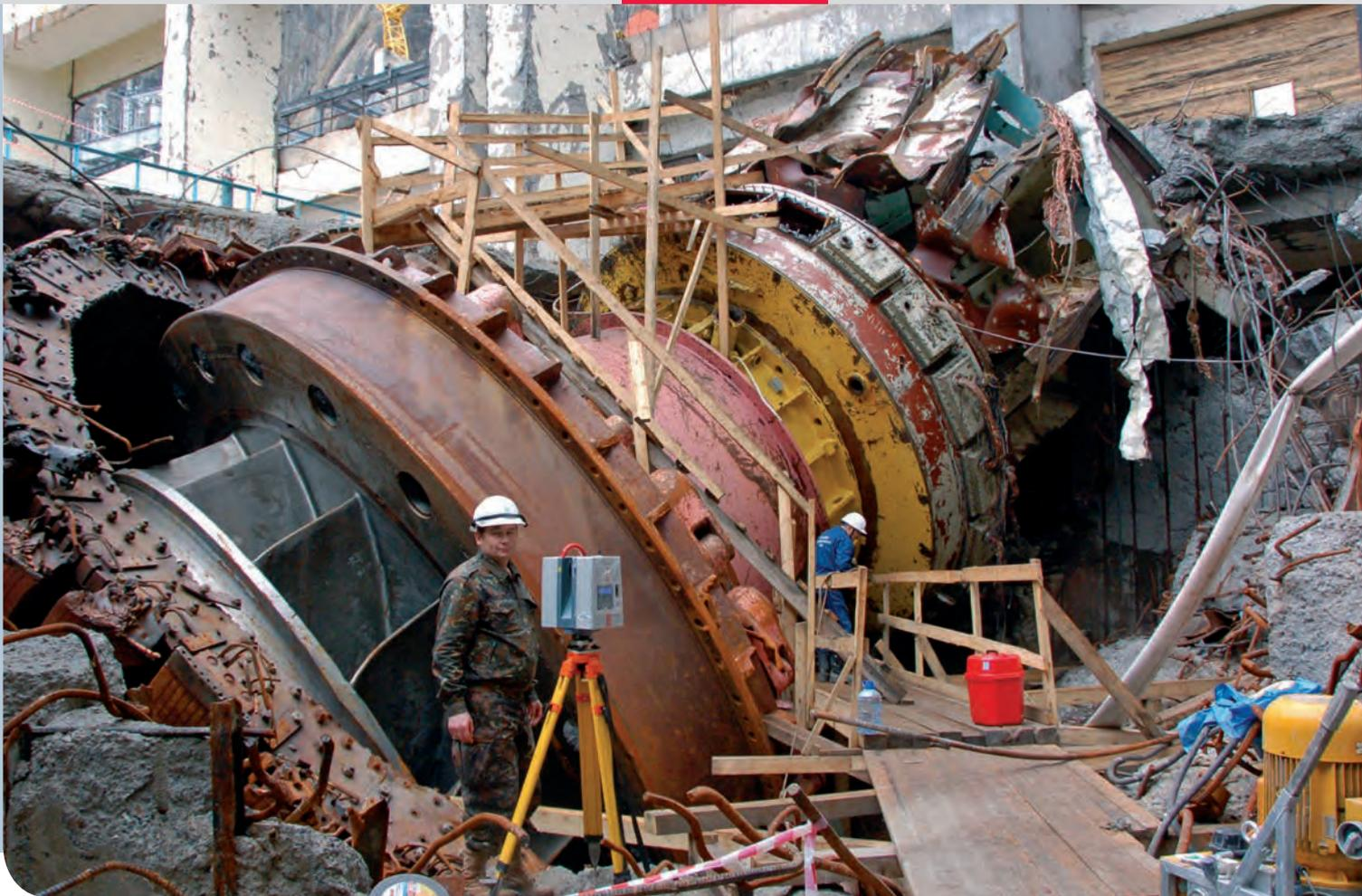
estación total para la adquisición de datos, esto sólo era posible mediante un escaneo láser realizado por tres expertos del socio ruso de Leica Geosystems, Navgeocom Engineering.
