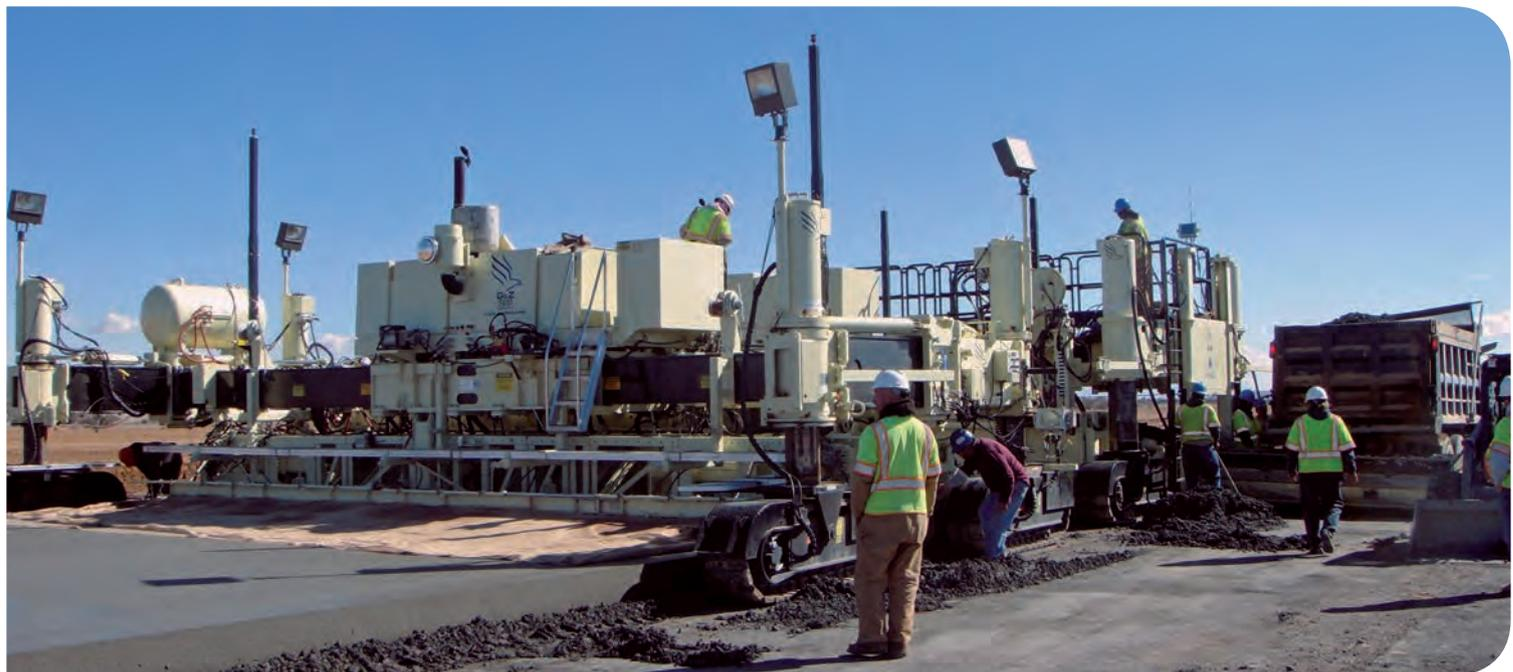
■ Montoya pavimentando la pista de aterrizaje con una extendedora de encofrados deslizantes S850 de Guntert & Zimmerman controlada automáticamente por un sistema Leica PaveSmart 3D.
