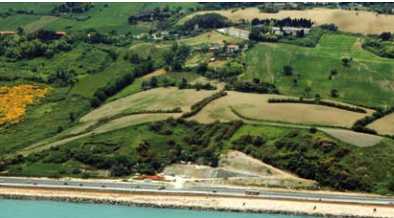
■ Vista actual del «gran desprendimiento de tierra».
