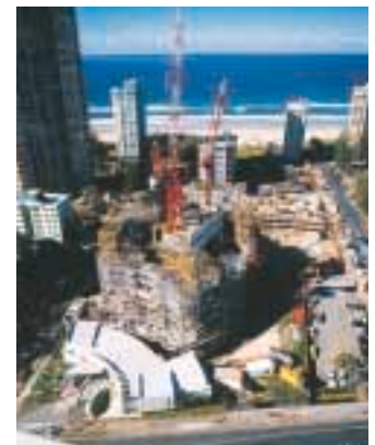
Abajo: La obra de la Q1 en julio de 2003. A la derecha: La obra en diciembre de 2003. Fotos: Cortesía de Sunland Group.
