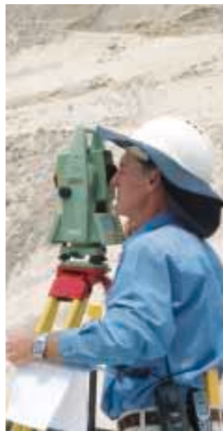
A la derecha: El ingeniero topógrafo Rod Stead, de Treasure and Associates, controlando la obra de la torre con la estación total Leica TCR1101.
