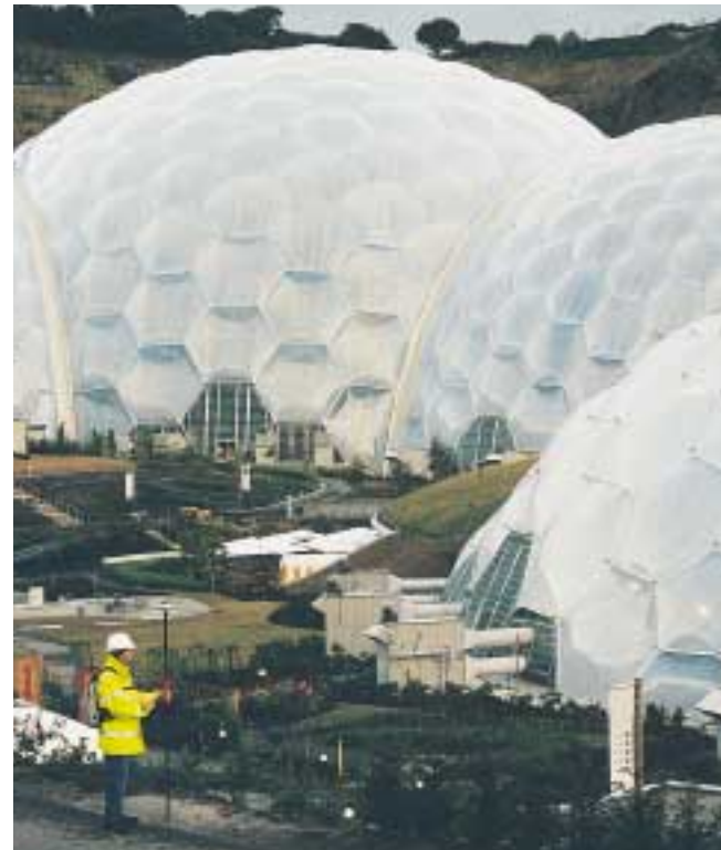
Tim Hall, del Ordnance Survey, midiendo para el proyecto Eden, un vasto paisaje de invernaderos bajo cúpulas geodésicas. Para actualizar los planos 1:2500 Tim Hall utiliza datos de corrección RTK transmitidos por teléfono GSM desde su oficina de Truro, situada a 27 km.
