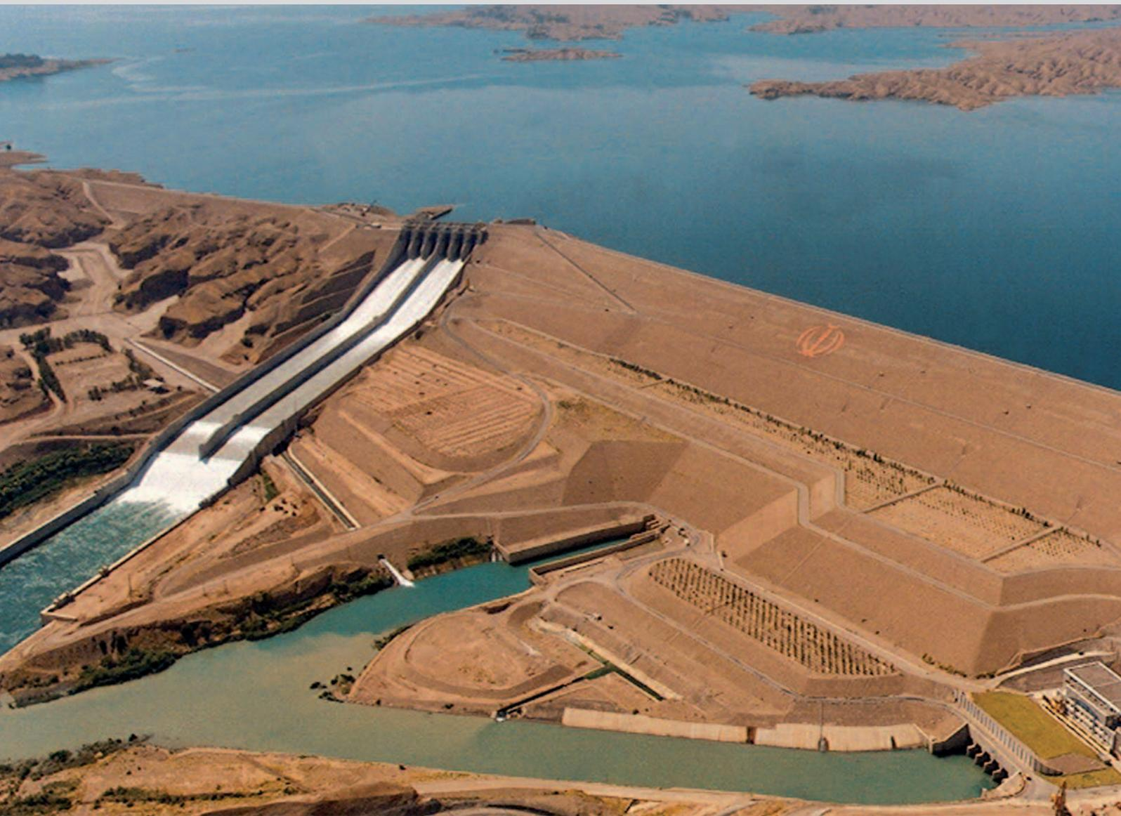
mueven más que los diques de hormigón. Por esta razón, recomendamos una combinación de redes de nivelación vertical de precisión y redes de monitorización por GPS para realizar el levantamiento topográfico del dique.»
