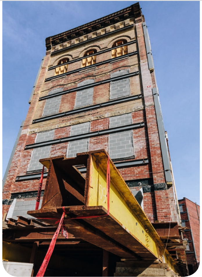
■ Desplazamiento de la casa hasta su nueva ubicación.
